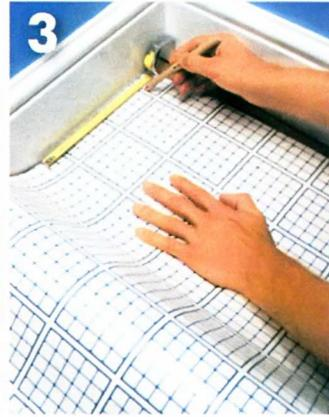
3 Край полотна прижимают к стене впритык и от ранее сделанной отметки откладывают те же 20 см.
