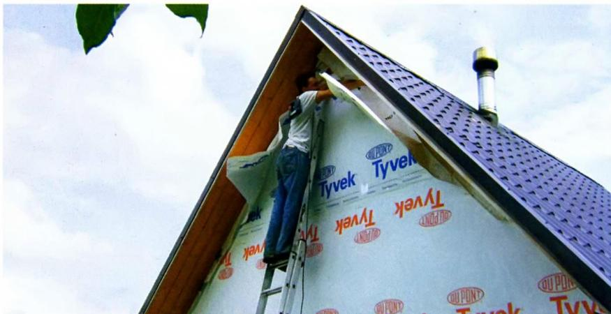
Закончив монтаж кровли, приступили к утеплению фронтонов. Ветро-влагозащитную мембрану прикрепили снаружи дощатой обшивки фронтона, а утеплитель потом укладывали, прижимая его к доскам обшивки со стороны чердака.
