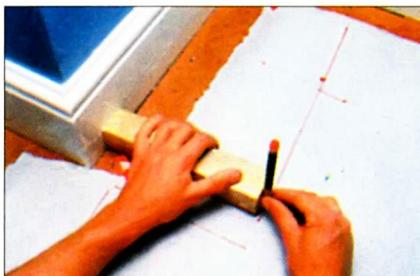
Фломастером, прикреплённым к короткой рейке, очерчивают контур стен. Шаблон готов. Остаётся только аккуратно снять его.
