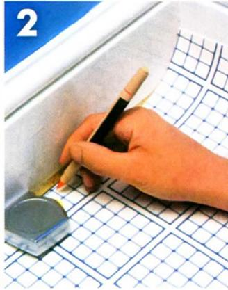
2 Чтобы точно отрезать полотно по длине, на нём с помощью рулетки делают отметку, например, в 20 см от стены.
