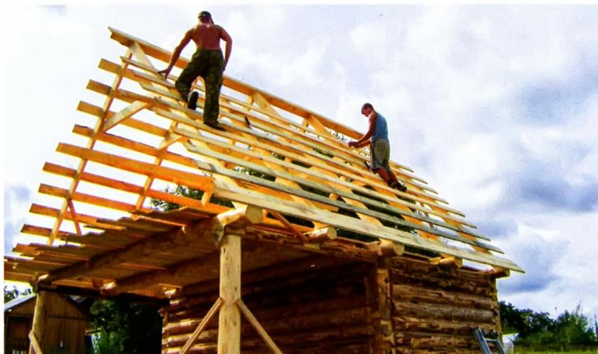
По балкам перекрытия уложили настил из досок, которые потом использовали для обрешётки. Стропильные фермы установили на выносы балок перекрытия и, зафиксировав внизу, сверху сформировали конёк из двух досок.
