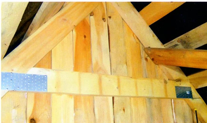
Последовательно одну за другой заменили временные затяжки на новые, выкроенные из доски сечением  $50 \times 150$  мм, устанавливая их горизонтально и на одной высоте от чердачного пола. К стропильным ногам затяжки крепили с помощью накладных перфорированных пластин.
