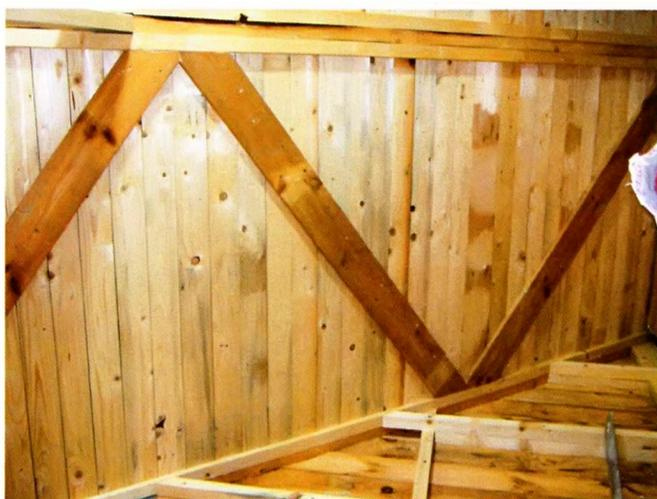
Чтобы доска ветрового крепления, идущая по диагонали всего ската внахлест по стропилам, не мешала укладке утеплителя и пароизоляции, её заменили компактной зигзагообразной конструкцией, углы которой упираются в черепные профили.
