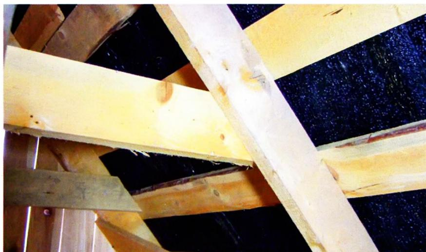
Затяжки стропильных ферм просто прибиты к стропильным ногам внахлёст. Функцию свою они выполняют, но при монтаже черепных брусков будут мешать.
