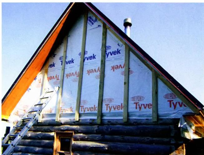
Края подкровельных плёнок приклеили поверх фронтовой и прибили скобками. Для обрешётки под обшивку «имитацией бруса» использовали обрезную доску сечением 25 × 100 мм.
