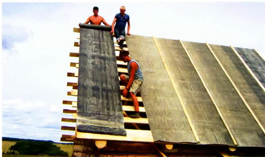
В качестве временной кровли использовали рубероид, полосы которого укладывали с небольшим нахлёстом поперёк досок обрешётки. Полосы крепили рейками по краям.
